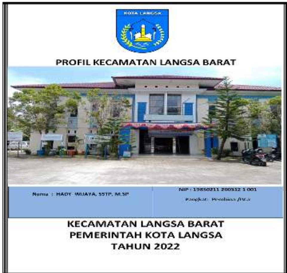
Gambar 1.1 Foto Kantor Kecamatan Langsa Barat
