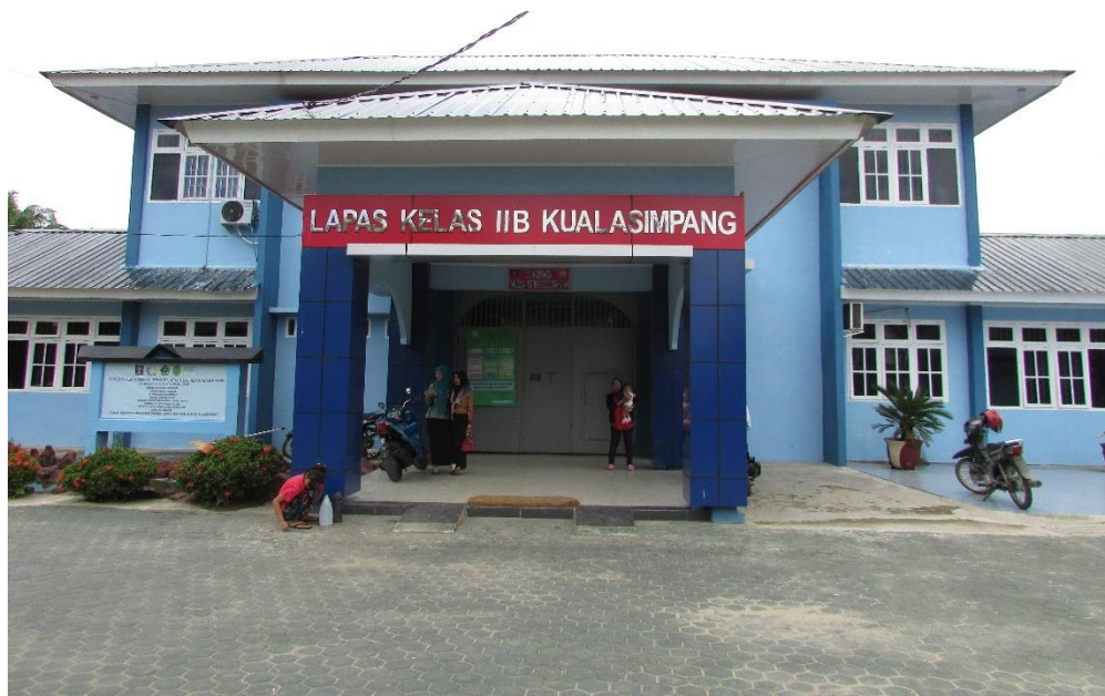
Bangunan Depan Lembaga Pemasarakatan Kelas II B Kualasimpang
