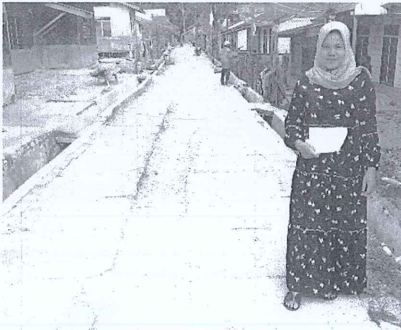
Foto peneliti mengamati pekerjaan jalan Beton dari Anggaran Dana Gampong di Gampong Sekualan
