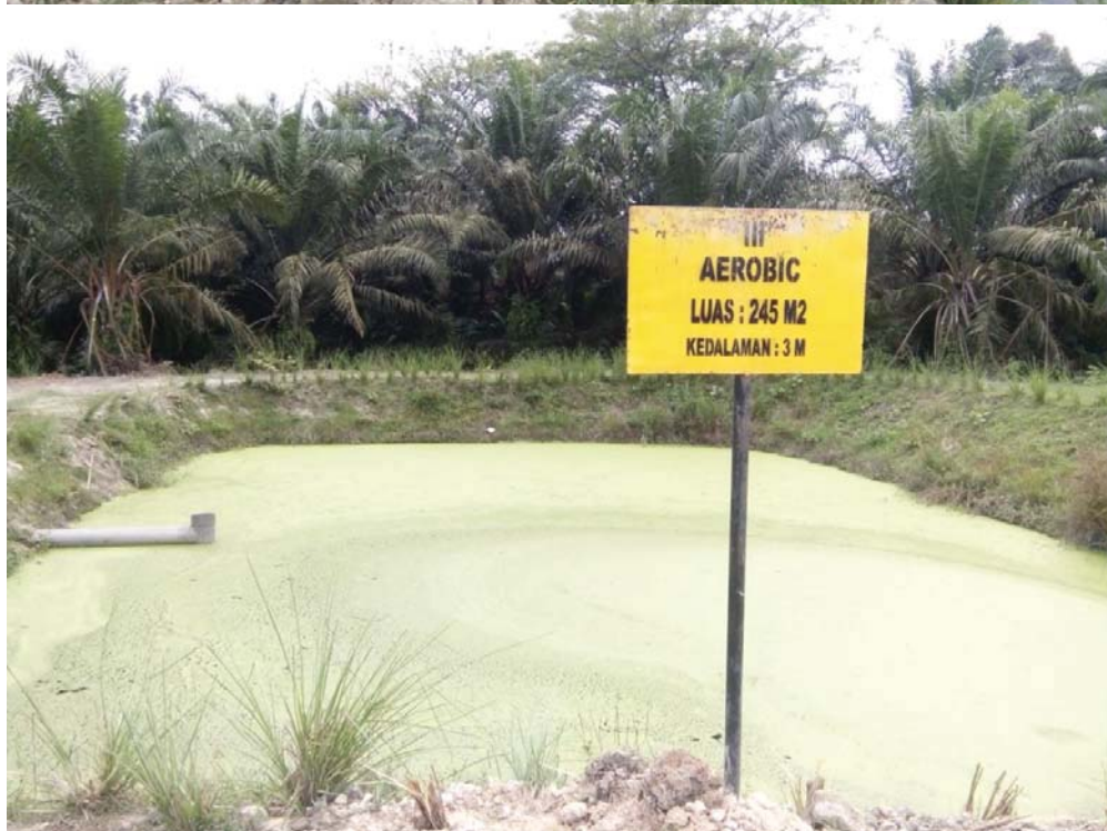
Ket: Pengolahan limbah Aerobik disekitar PT. PP. Pati Sari
